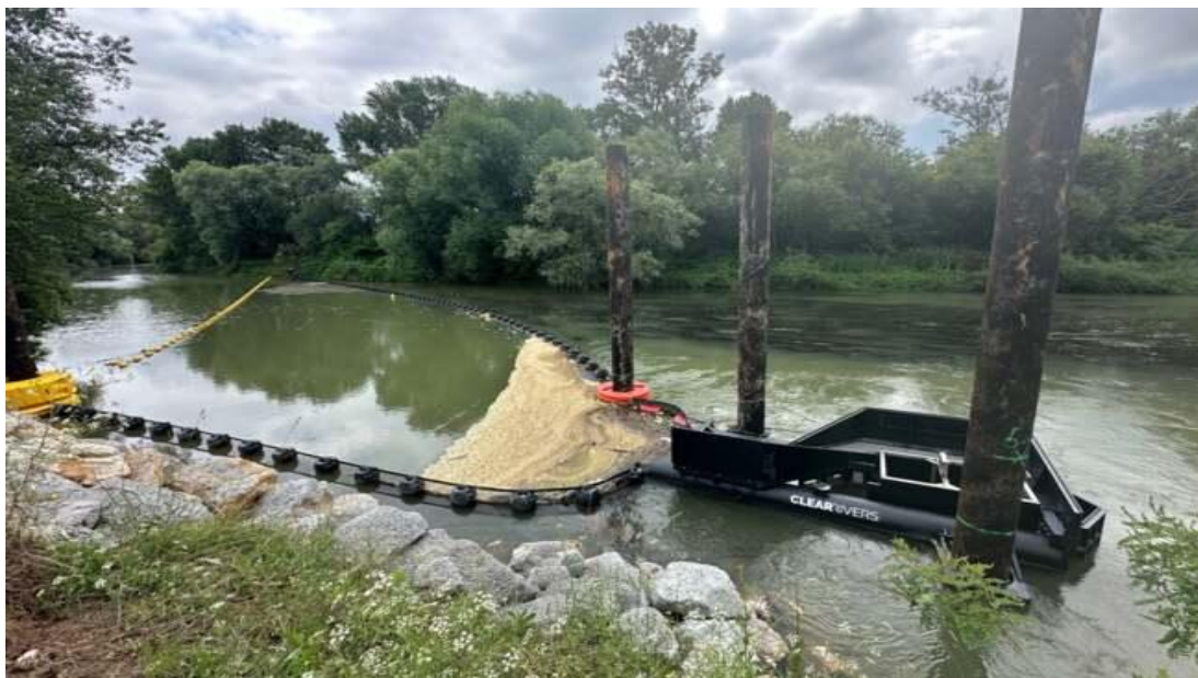
Crișul Negru la Tinca, barieră plutitoare de tip Litter Trap pentru colectarea deșeurilor (Sursa foto: ABA Crișuri)
